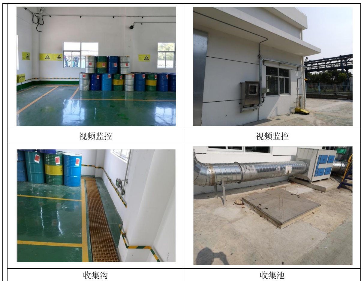
图 3-3 危险废物贮存场所设置情况
