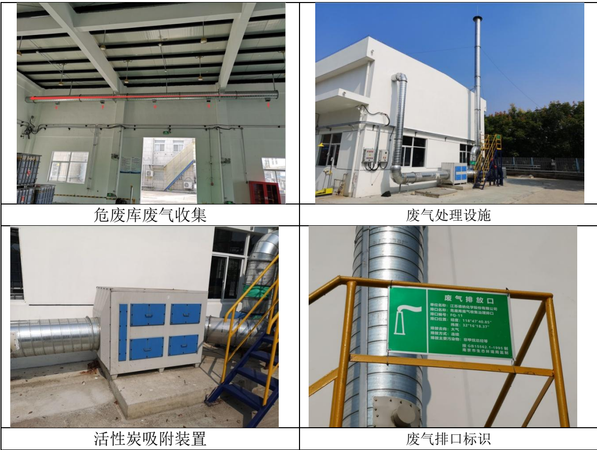
图 3-1 废气处理装置及标识标牌
