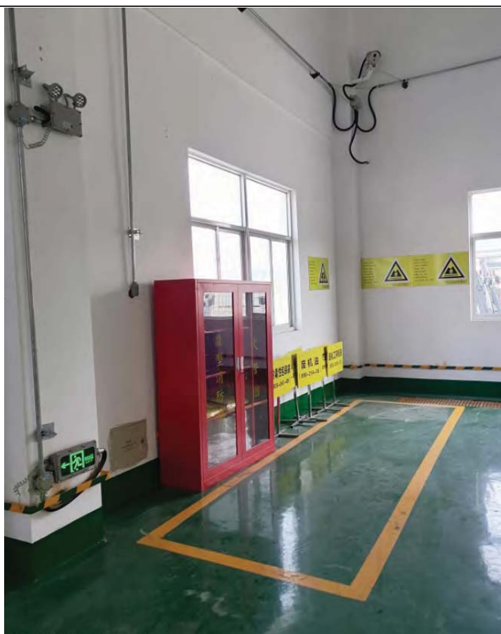
危废库内部照片
