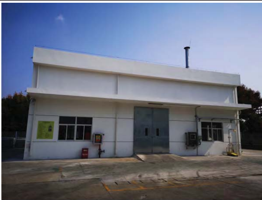
危废库现场照片
