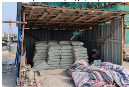
图 6.1-6 施工材料定点堆放
