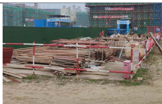
图 6.1-4 建筑材料堆场
