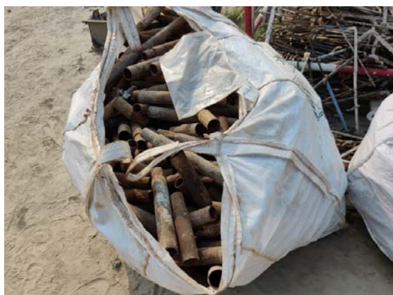
图 6.1-1 施工材料包裹后放置
