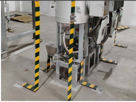
图 6.1-17 电气设备接地措施
