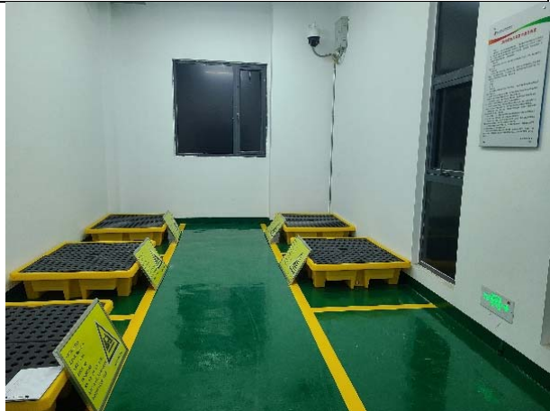
图 6.1-22 危废仓库内部防渗托盘、环氧地坪、分区、监控和标识牌
