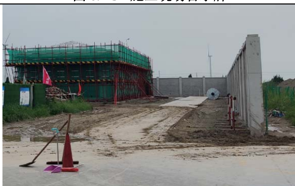
图 6.1-5 陆上施工区边界围挡
