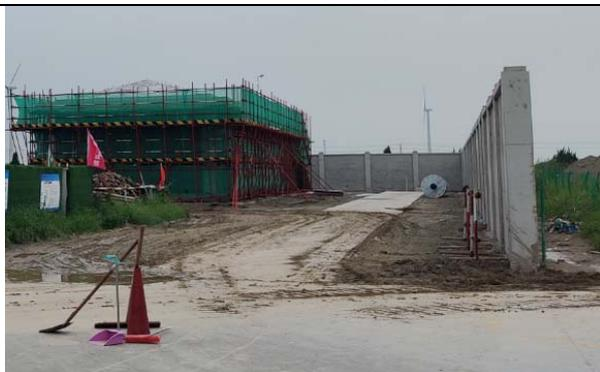
图 6.1-5 陆上施工区边界围挡
