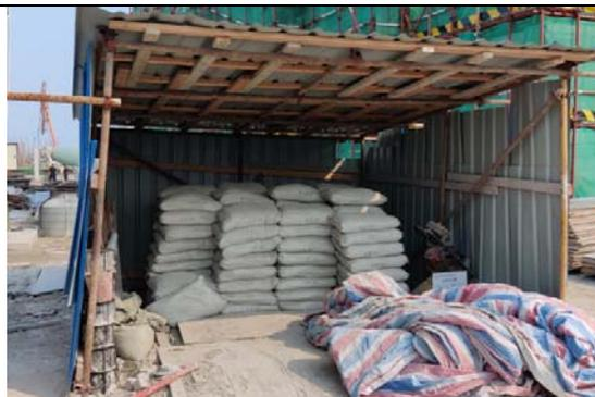
图 6.1-6 施工材料定点堆放
