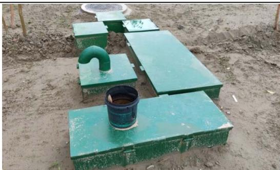
图 6.1-10 陆上集控中心地埋式污水处理设施
