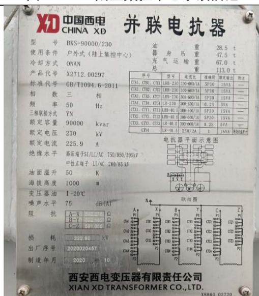
图 6.1-14 集控中心低噪设备规格铭牌
