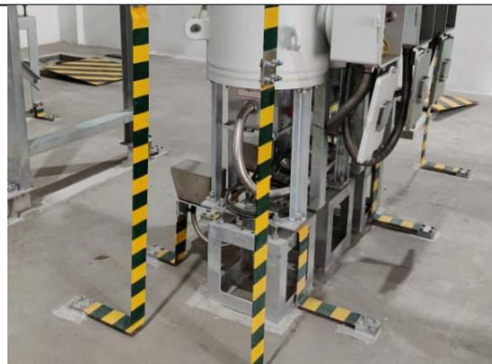
图 6.1-17 电气设备接地措施
