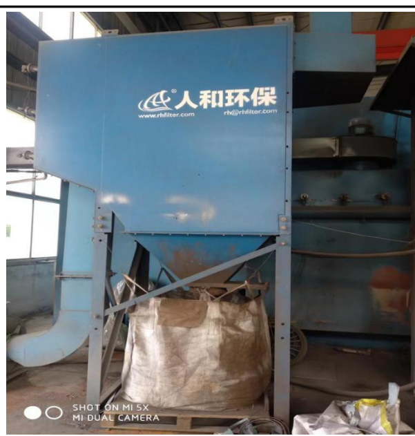
沉流式滤筒除尘器
