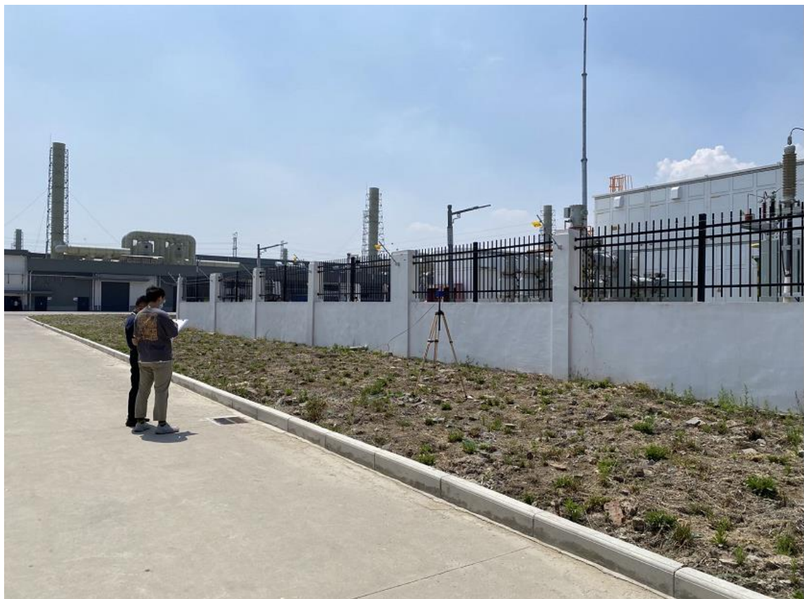
图 7-2 110kV 总降变南侧工频电场、工频磁场监测照片
