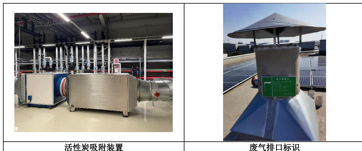
图 3-1 废气处理装置及标识标牌
