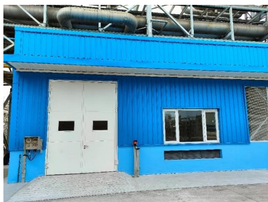
润滑油站外部
