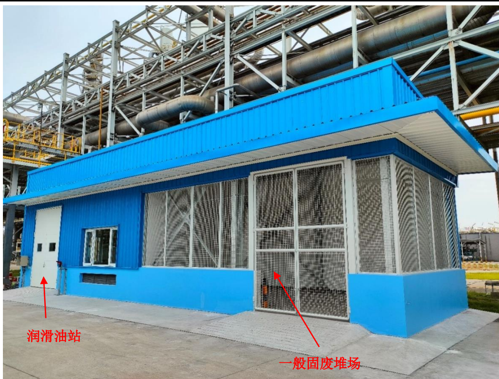
润滑油站及一般固废堆场外貌
