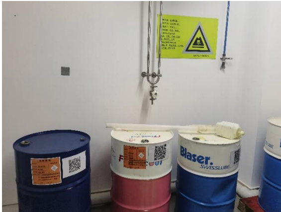
危废暂存间内部
