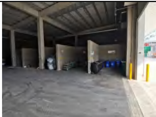
一般固废暂存库内部
