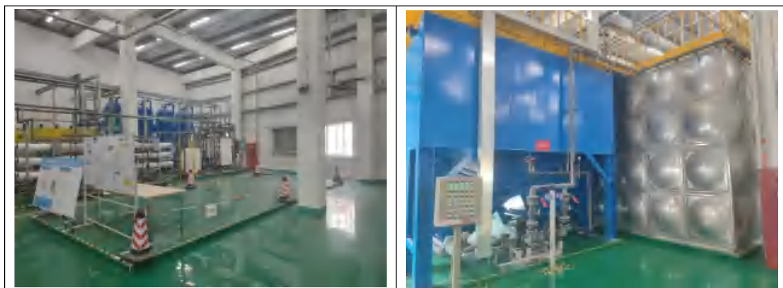
图 4.1-2 污水处理站现场照片
