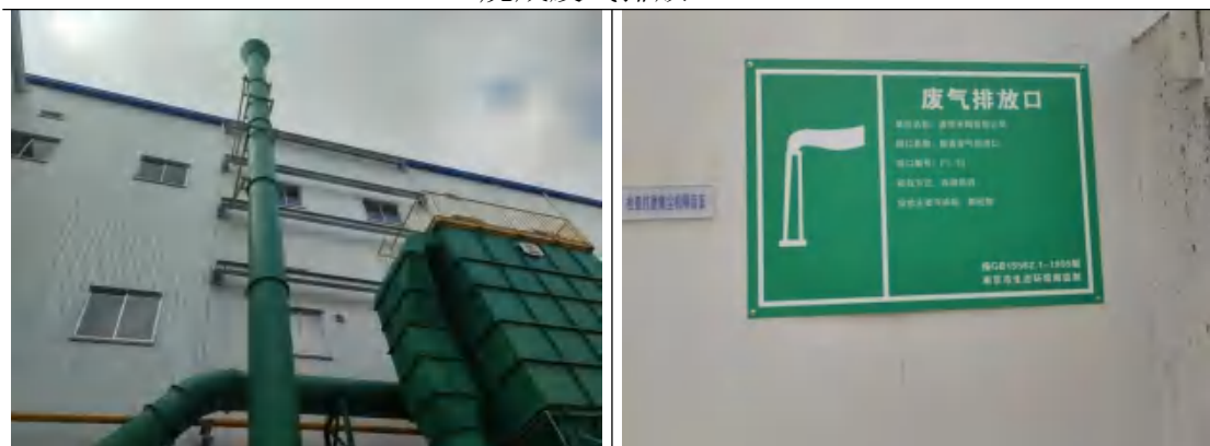
8、检查废气排放口 F1-10
