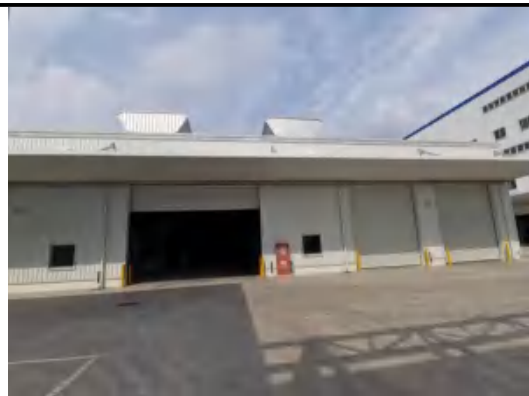
一般固废暂存库外部
