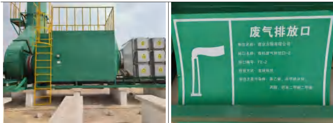
10、腻子刮涂、OF 配管取付废气排放口 F2-2
