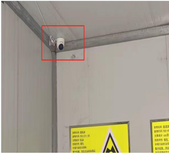
废气收集口及摄像头
