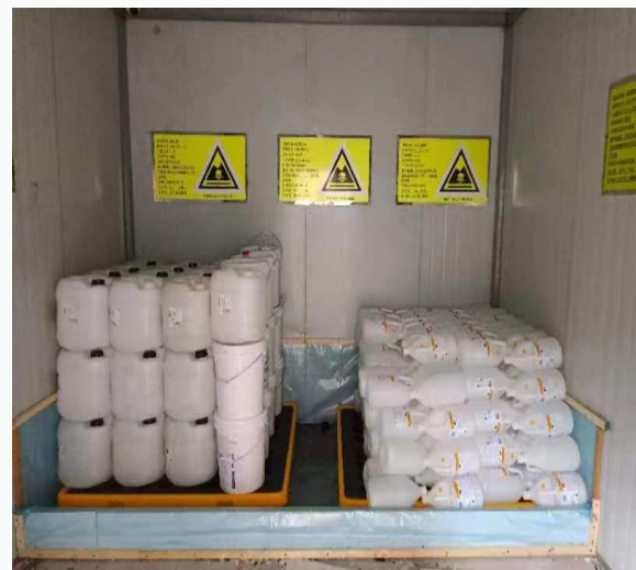
危废暂存间分区摆放
