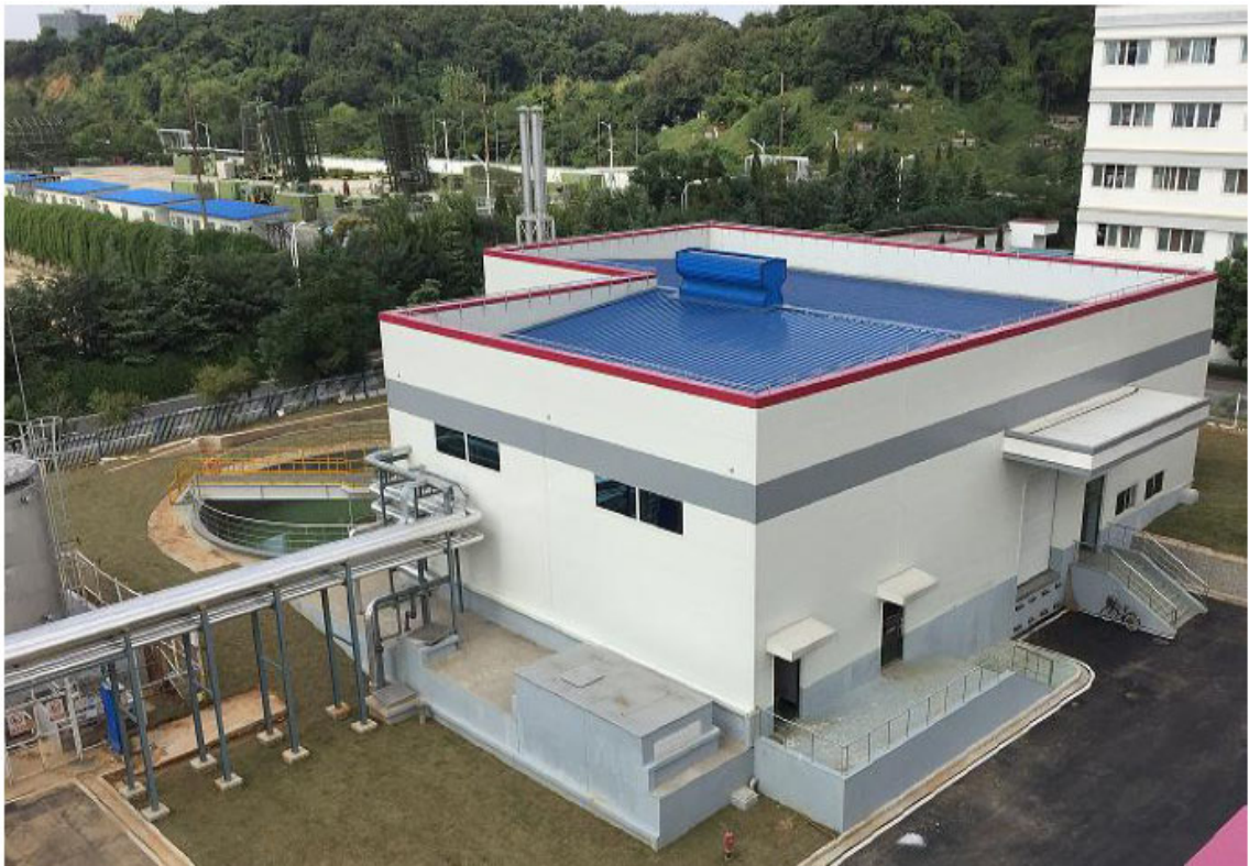
图 3-1 厂内污水处理站现场照片
