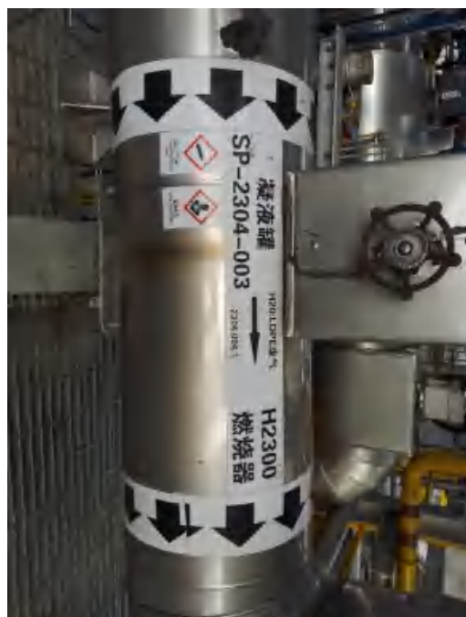
高压聚乙烯装置 LDPE 分子筛吹扫尾气
