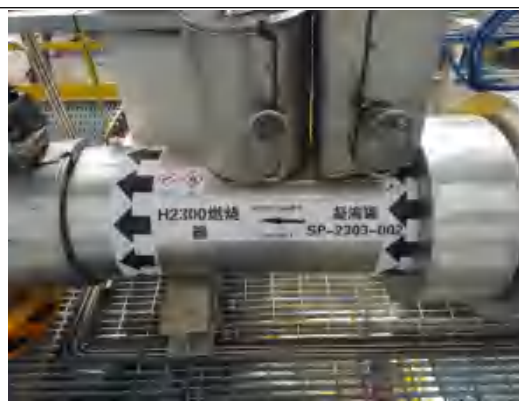
乙苯/苯乙烯装置
