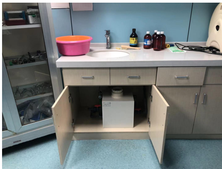
图 3-2 化验室小型医疗废水处理设施照片
