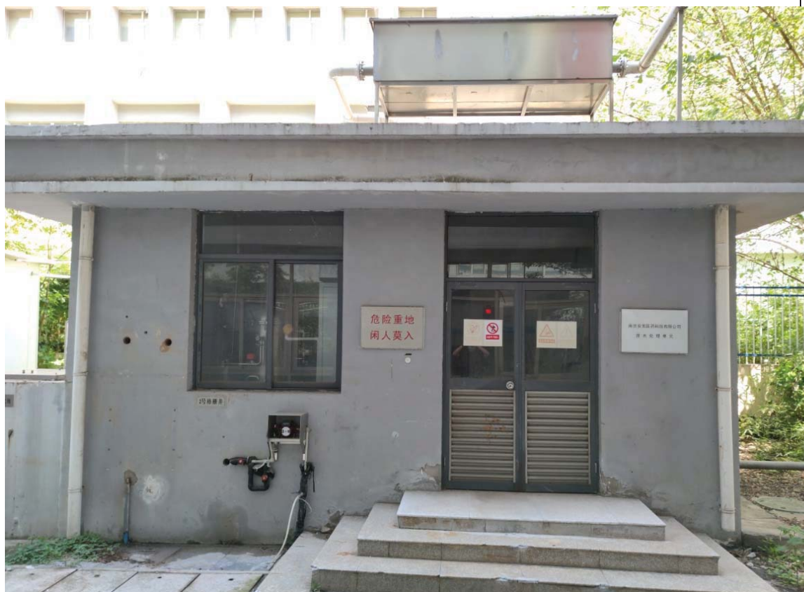
污水处理站照片
