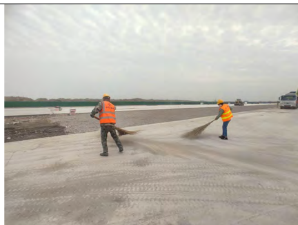
施工场地清扫
