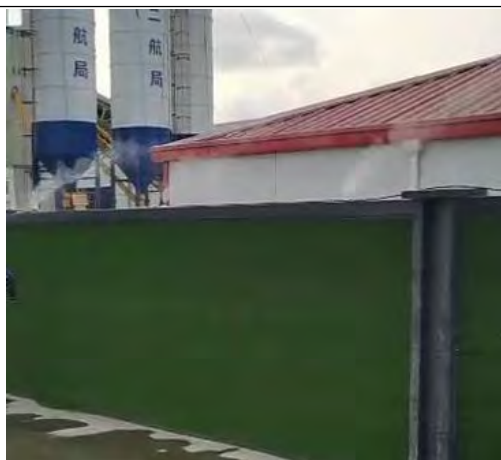
施工围挡配备除尘装置（喷雾）
