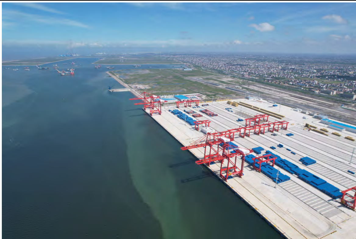
码头前沿港池
