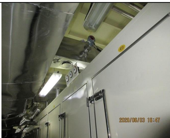
图4-8阳极干燥工段有机废气收集、处置现场图（工段密闭、三级水喷淋吸收装置处置）
