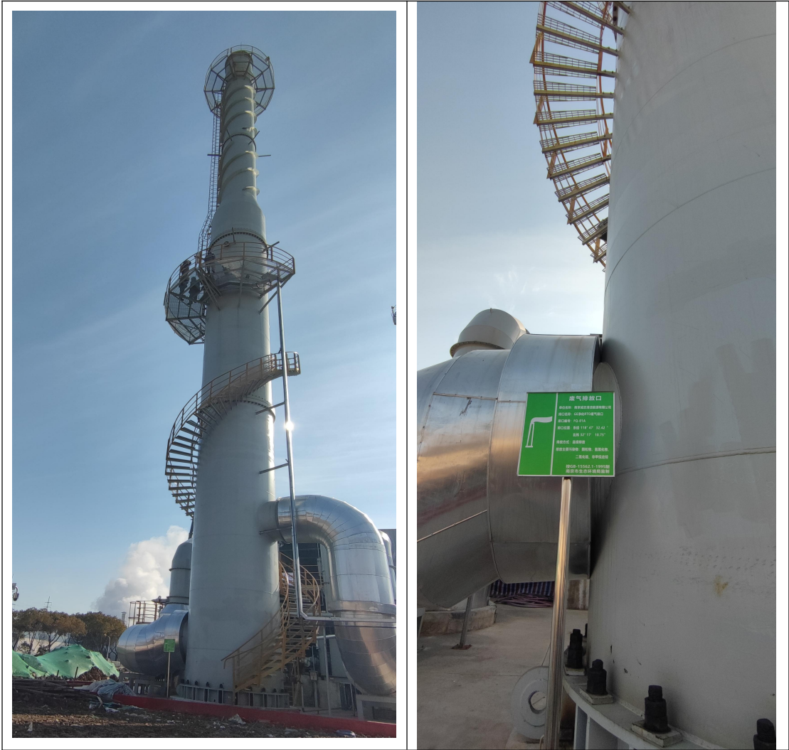
图 3-2 废气采样点及环保标识牌
