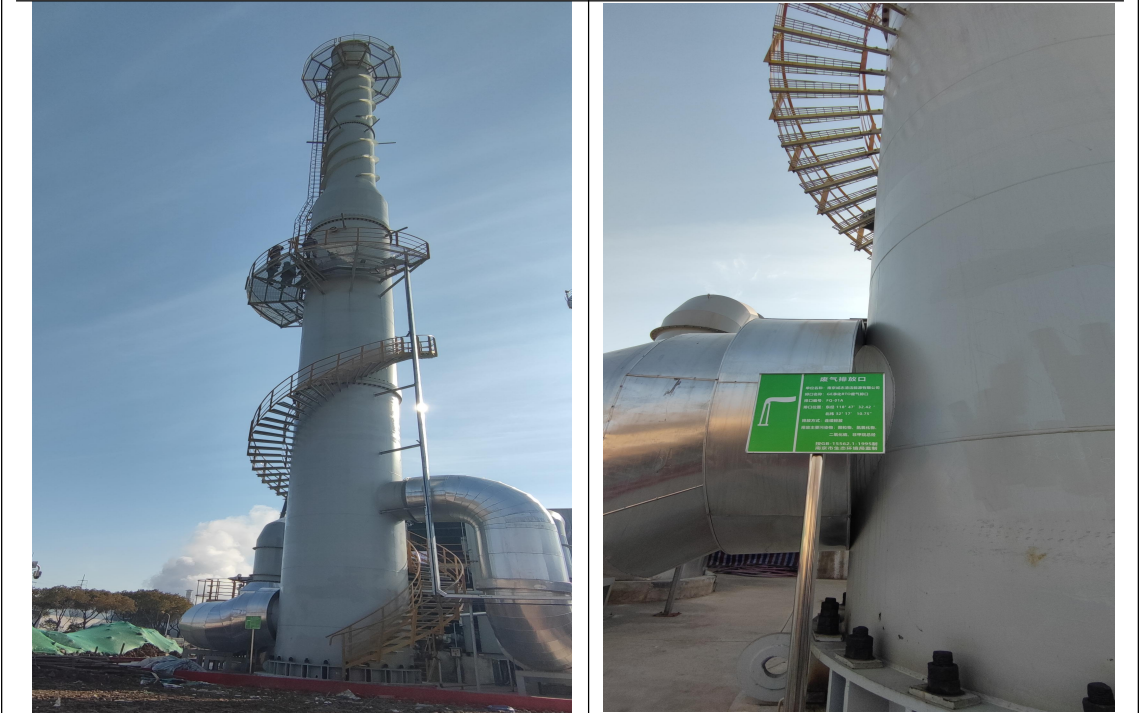
GE 净化 RTO 装置在线监测设备平台和在线监测站房
