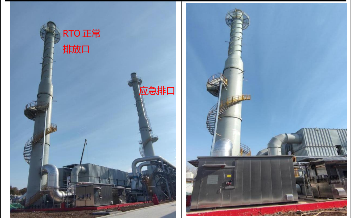
GE 净化 RTO 装置在线监测设备平台和在线监测站房
