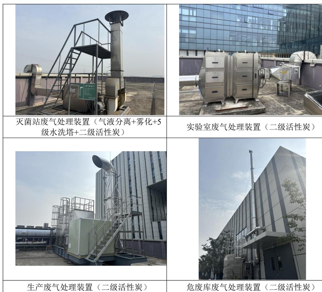
图 3-2 本项目废气处理装置图
