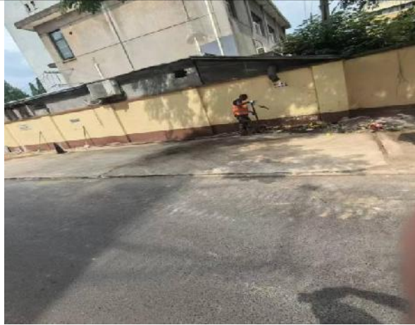
富贵山小区积淹水应急改造工程（工程1）临时占地现场恢复
