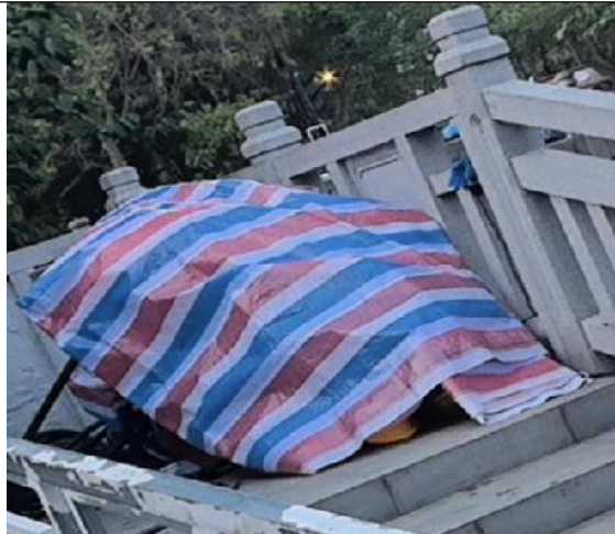
施工过程中物资材料防雨布遮盖
