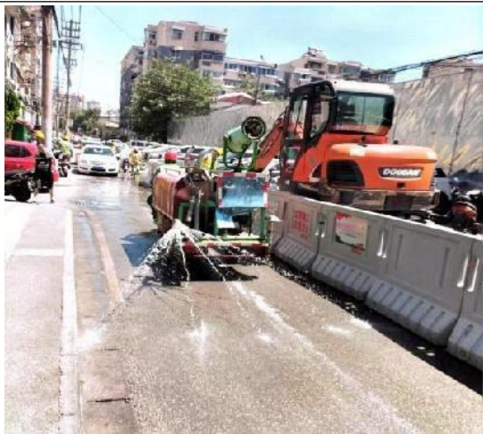
施工废水回用于洒水降尘
