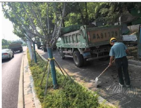
施工清扫，避免施工扬尘
