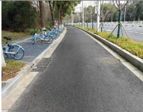
翠屏紫气钟山小区节点井上游排水管道改造工程（工程3）临时占地现场恢复
