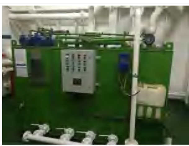
图 5.4-2 船舶生活污水处理装置
