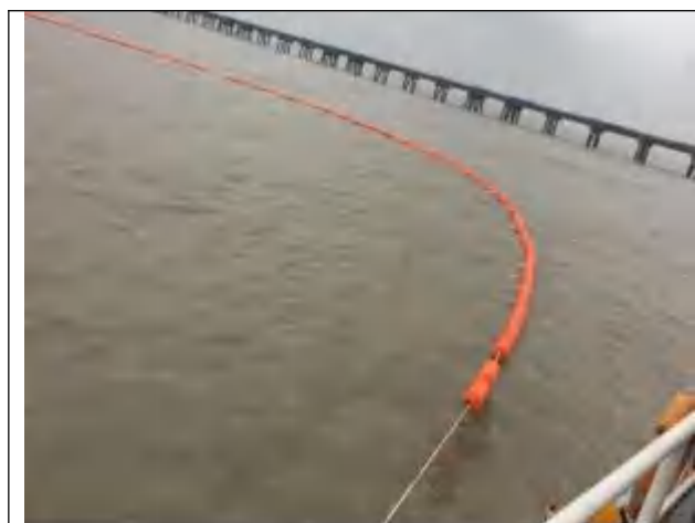
图 5.4-1 疏浚船舶施工区域设置围油栏
