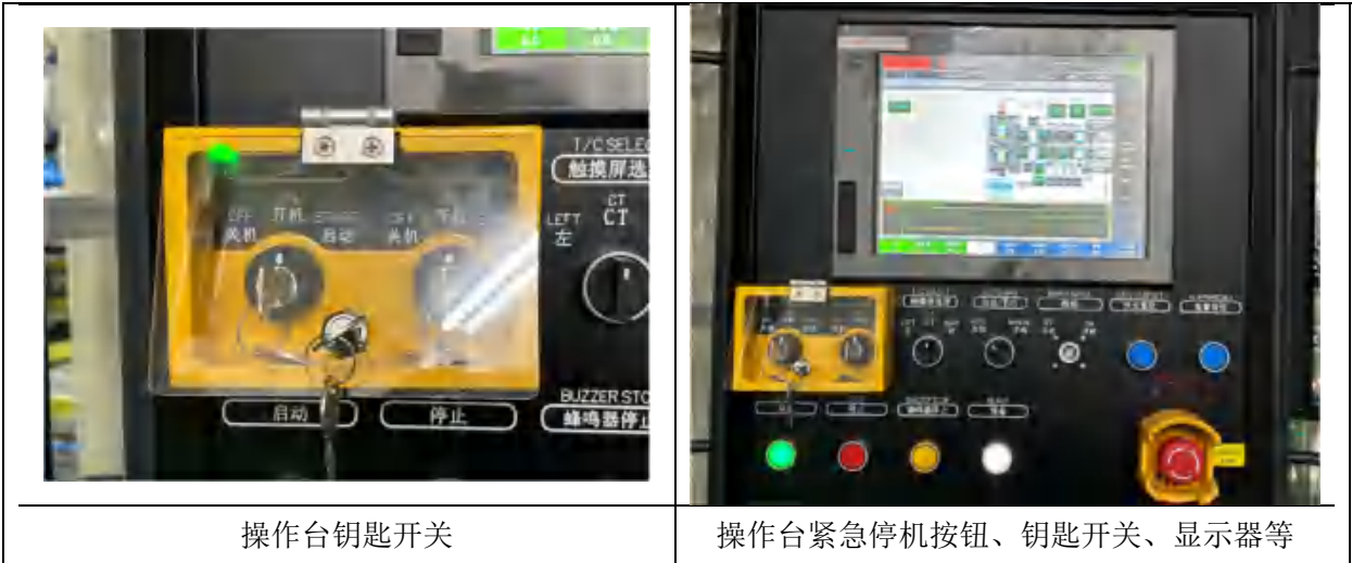
图 3-2 辐射防护安全措施情况现场图
