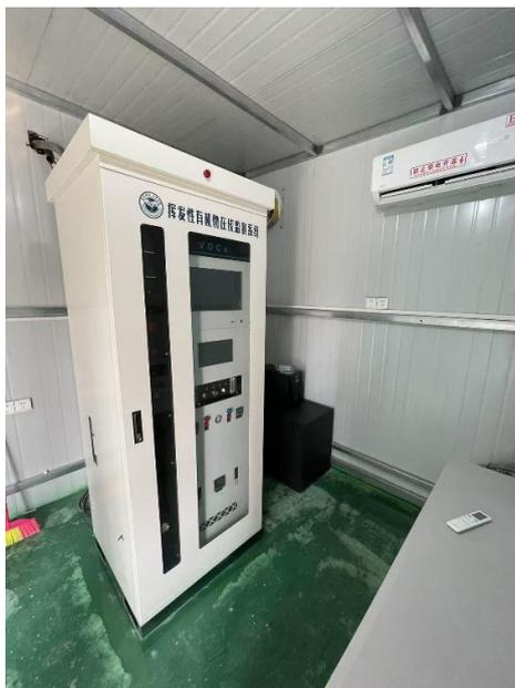
图 4.2-1 VOCs 在线监测系统现场照片
