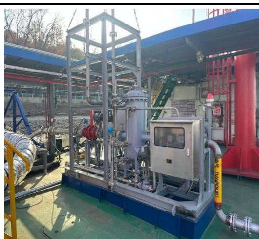
船岸对接设施
